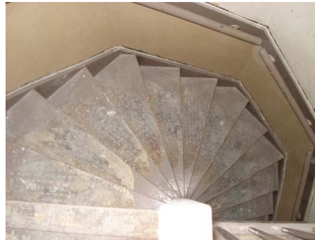
4: Interieur: authentieke details zoals tegels (vloeren en vensterbanken) evenals indeling (met oorspronkelijke trap, zie boven) goed bewaard gebleven.
