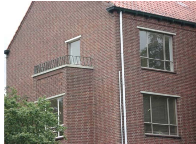
4: Detaillering kopgevel van bouwblok aan de Anthoni van der Heimstraat: metselpatroon op borstwering balkon, balkonhek en stalen raamtraceringen.
