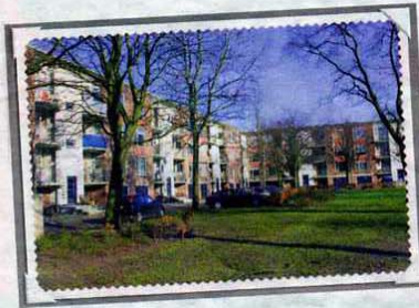
De Pieter Steynstraat in de Zwolse wijk Dieze-Oost. Het vele groen tussen de woningbouw compenseerde destijds het kleine balkonnetje dat bij de woningen zat. foto Tom van Dijke
